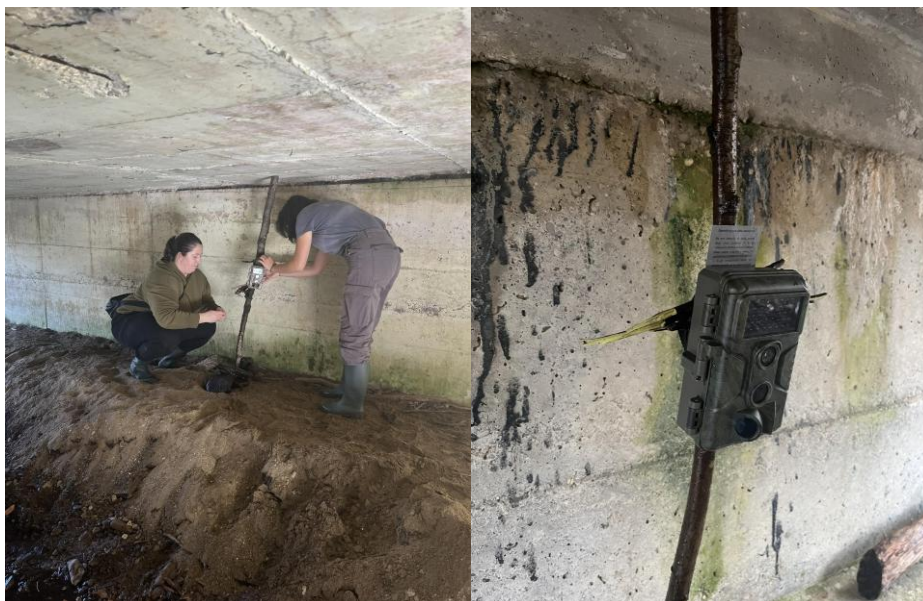
Slika 16 Postavljanje foto pasti pod mostom in prikaz opozoril o snemanju okolice (foto: Neža Brlan)
